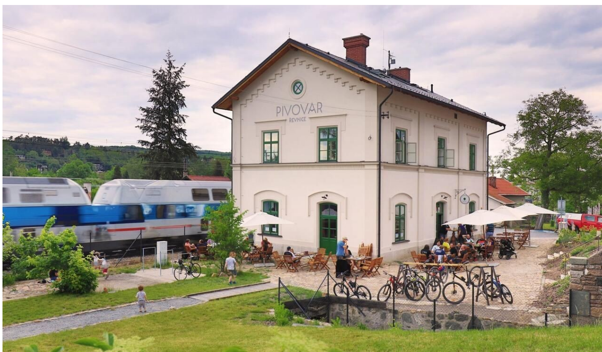
Minipivovar Řevnice – příklad úspěšné konverze a oživení nepotřebné drážní budovy (zdroj: mapy.cz)
