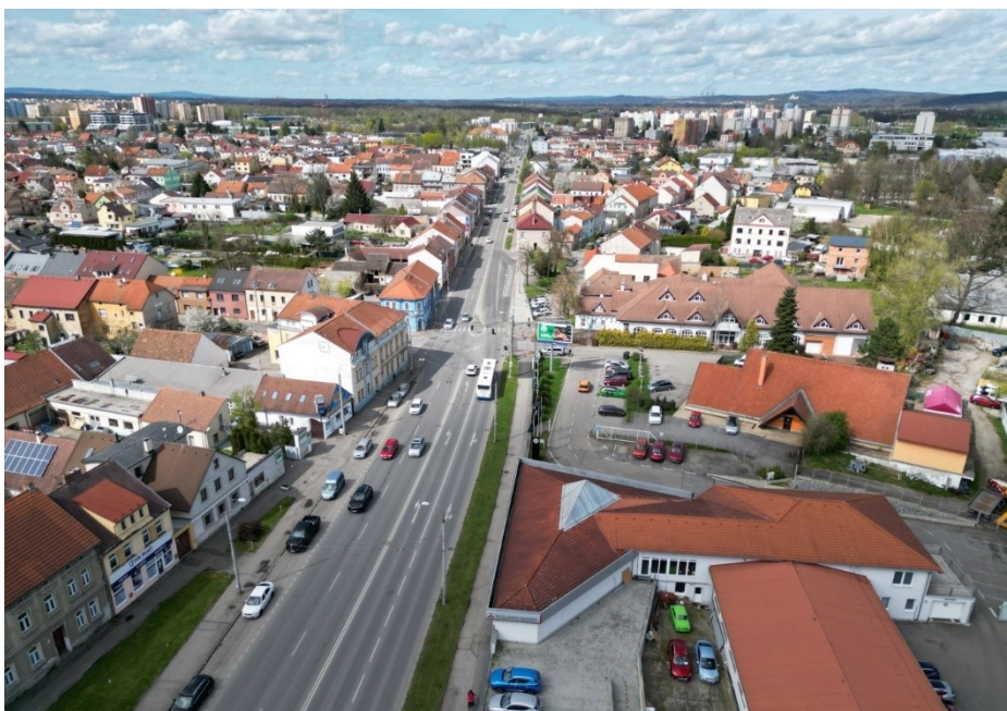
Husova ulice v Českých Budějovicích - současný stav.
