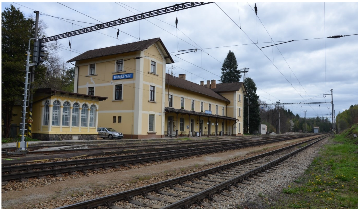
V budoucnu rušená železniční stanice Hluboká Zámostí
