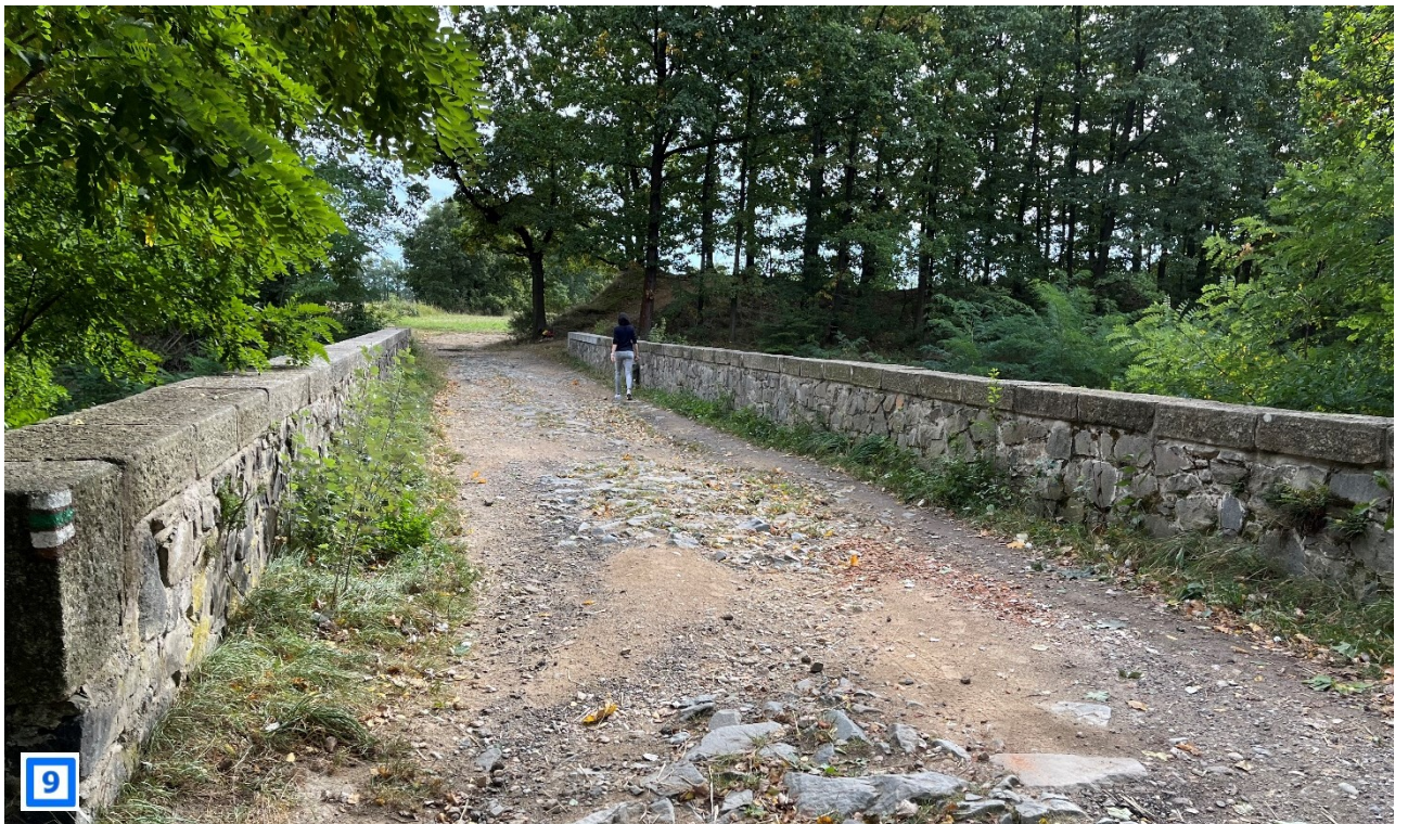
Most přes železniční tras – vstup do krajiny (turistická trasa)
