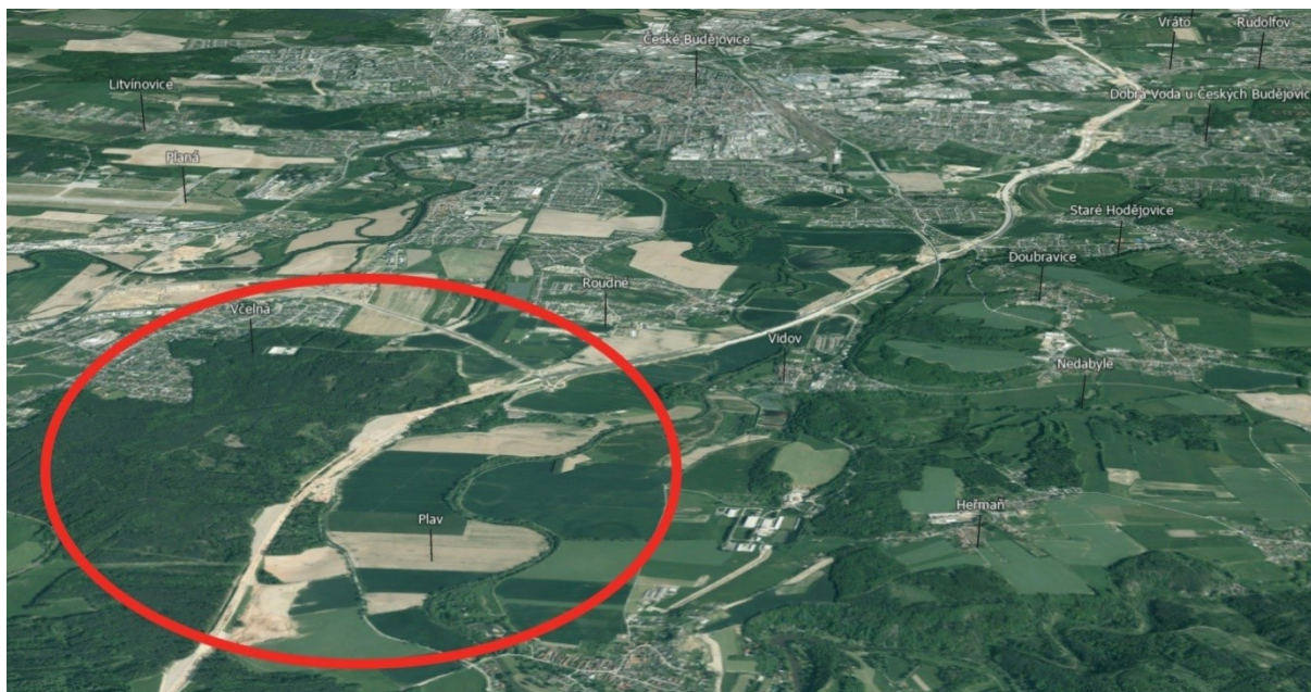
Současná stavba dálnice D3 jako do velké míry nepřekročitelná bariéra v krajině. Červeně je vyznačeno místo zářezu u Rožnovského lesa na západní straně nivy Malšův.
