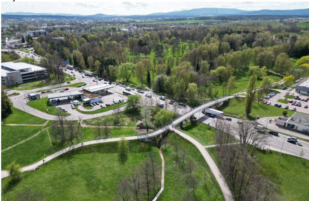
Komunikace I/3 Na Dlouhé louce - současný stav.
