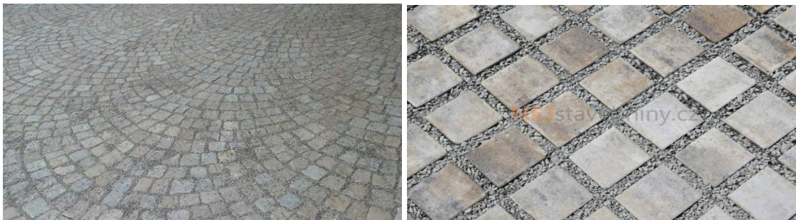
Příklad propustných a polopropustných zpevněných ploch, ploch umožňujících prorůstání zeleně.
