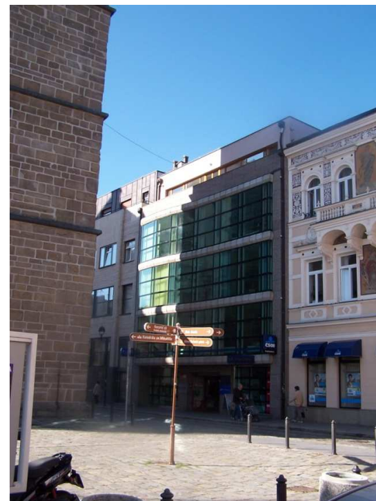
Multifunkční dům U Černé věže 3
