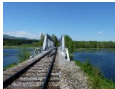
Rekonstrukce mostu u zast. Žlábek
