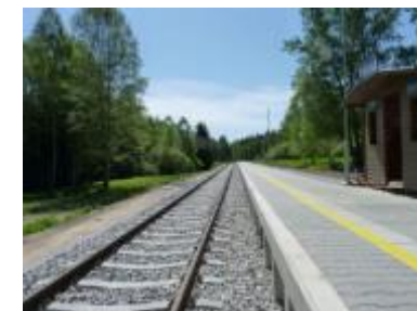
Zastávka Pernek po realizaci
